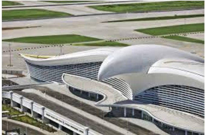
Von Zambelli gefertigtes Dach des Flughafens Ashgabat / Turkmenistan
